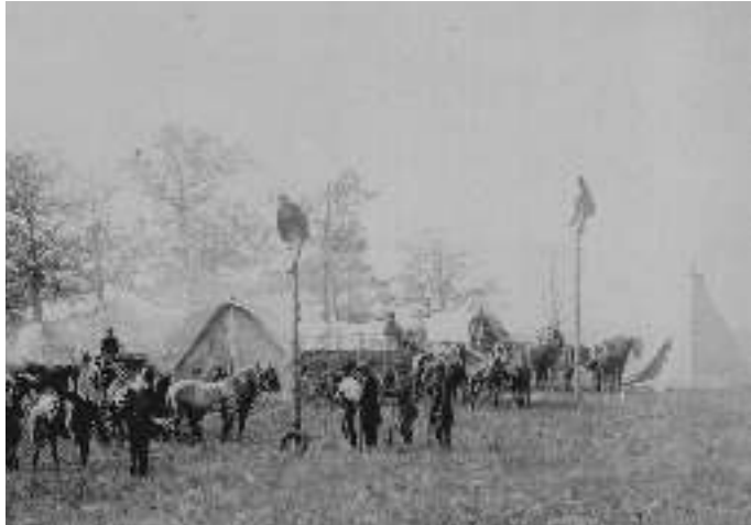
Errichtung von Telegraphenmasten
