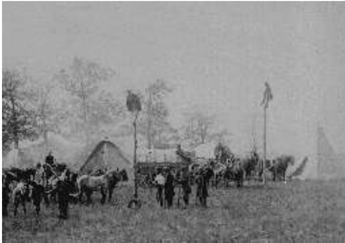
Errichtung von Telegraphenmasten
