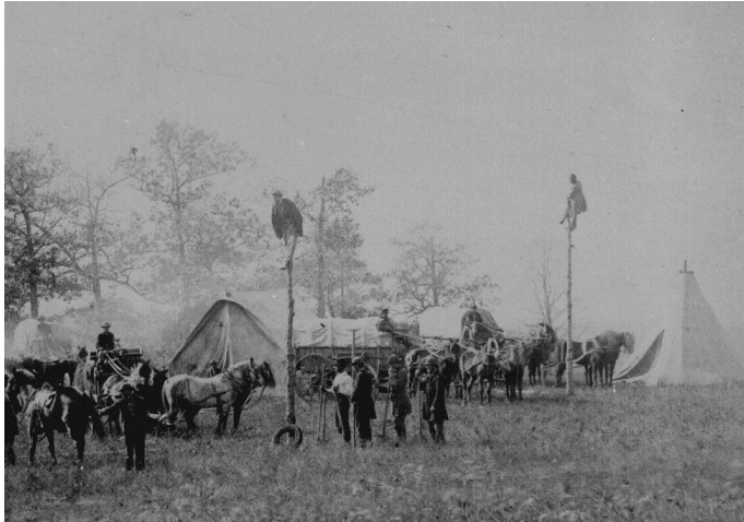
Errichtung von Telegraphenmasten
