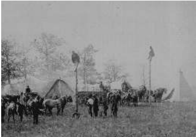
Errichtung von Telegraphenmasten
